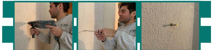
En caso de paredes muy deterioradas, perforar con mecha de Vidia y Utilizar tarugo y tornillo, el cual queda oculto en el centro de cada panel.
